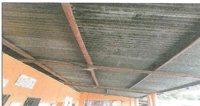
Foto 4: Láminas y costaneras en mal estado
