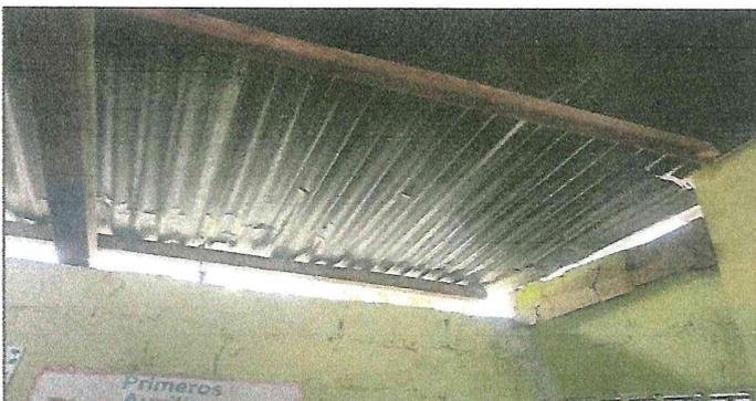
Foto 3: Láminas en mal estado
