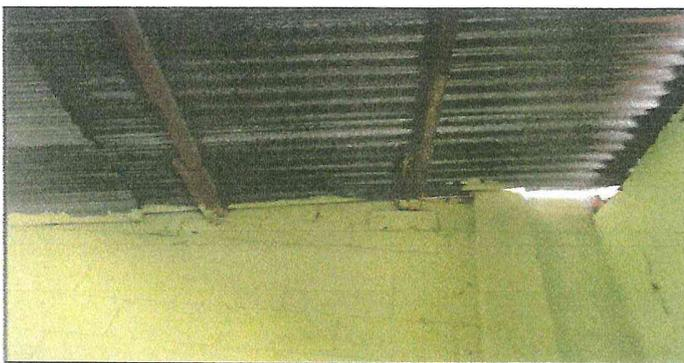
Foto 5: Láminas para sustituir
