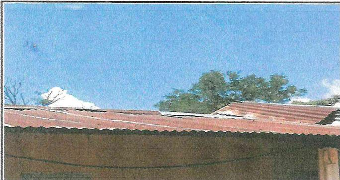
Foto 1: Láminas en mal estado
